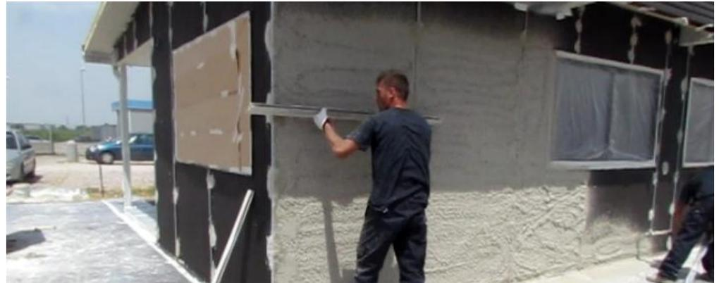
Applicazione uno strato uniforme di intonaco, fino al raggiungimento dello spessore ideale e successivamente procedere alla staggiatura.
