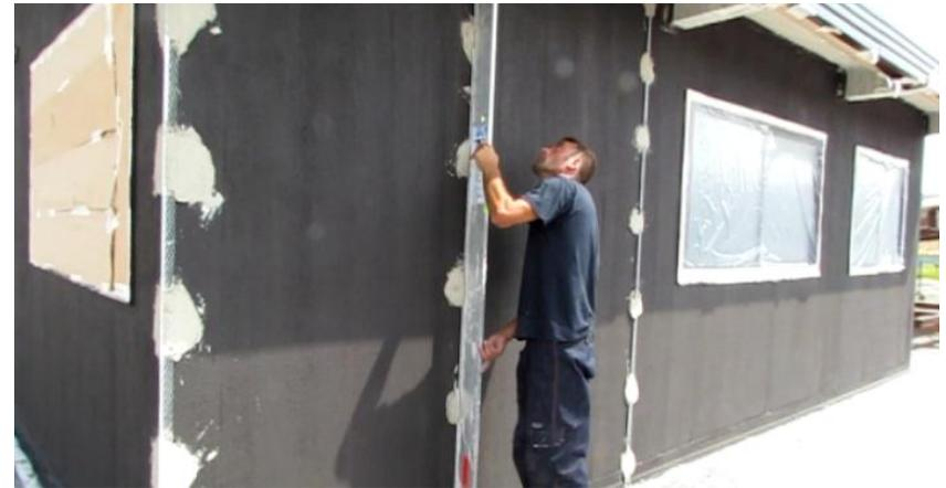
Posizionamento angolari e profili per intonaco, mettere in bolla in modo da ottenere una perfetta linearità della parte.
