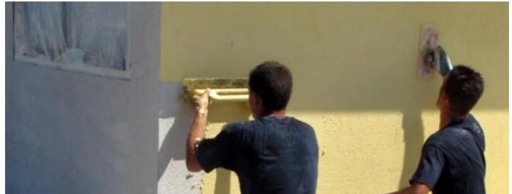
Realizzazione del manto di finitura mediante frattazzo in plastica liscia.
